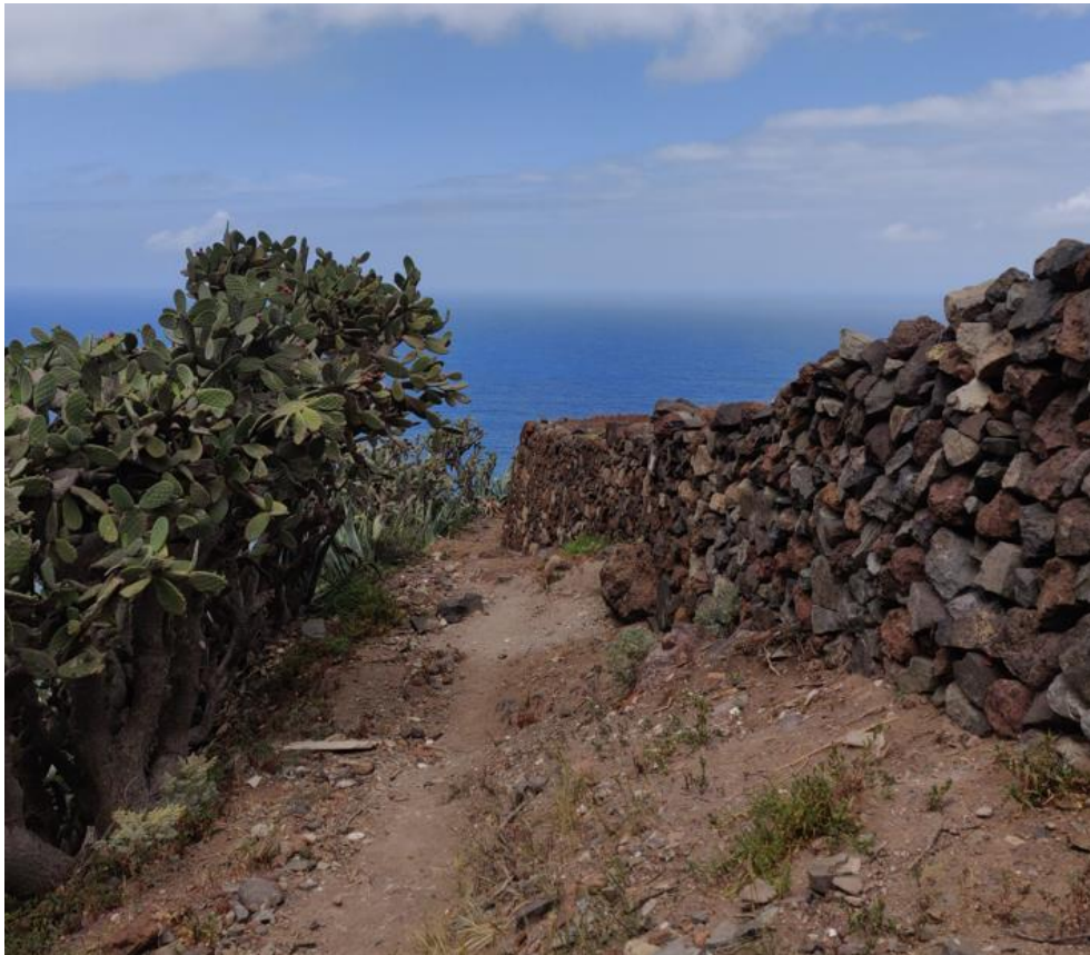
Ilustración 7: Muro de contención tradicional de piedra en seco, sistema empleado para la contención de aguas en el proyecto.
