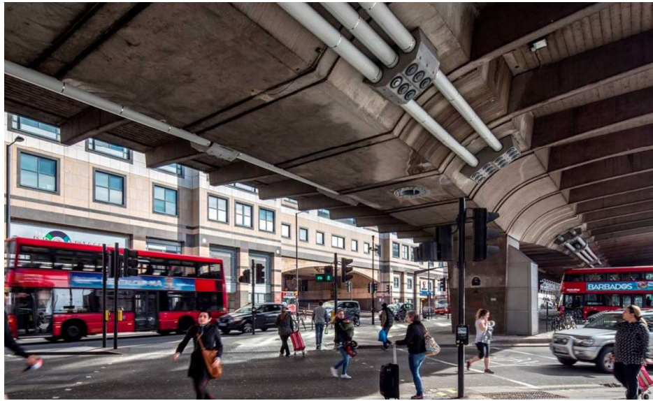
Fig. 1.7. Hammersmith Flyover. Refuerzo de puente con postensado exterior empenado cajones de anclaje de UHPFRC (Ductal).
