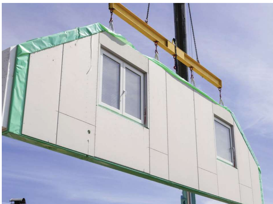
Fig. 1.1. Instalación de cerramiento modular prefabricado.
