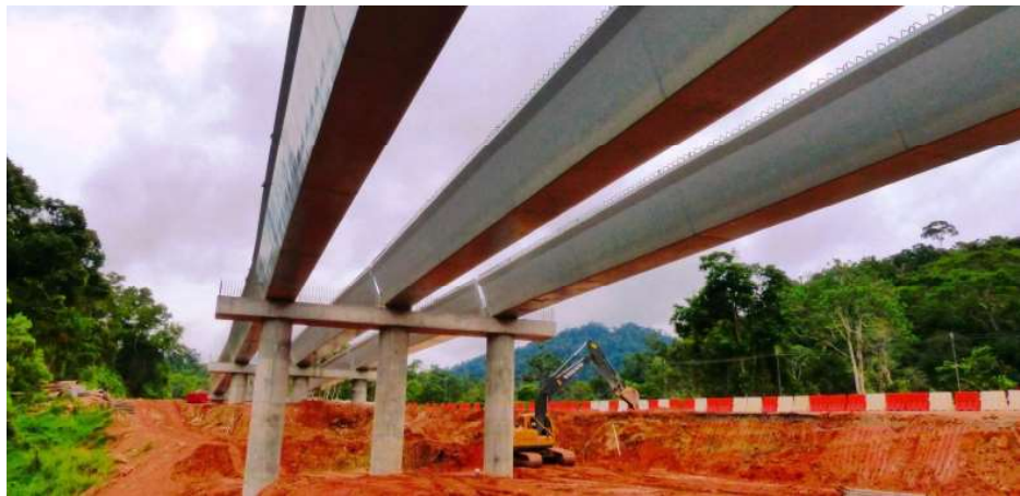
Fig. 1.8. Construcción de puente en Malasia, empleando vigas pretensadas en U de UHPFRC (Dura).
