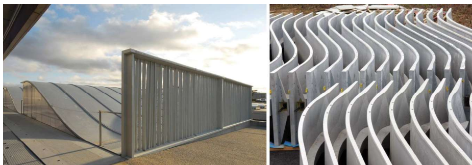
Fig. 2.23. Elementos secundarios de cubierta prefabricados en UHPFRC para la planta de tratamiento de aguas de Achères, Francia.
