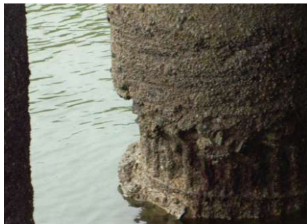
Fig. 2.4. (Izq.) Pilote de hormigón armado pretensado con pérdida de recubrimiento y corrosión de armaduras en entorno marino.
