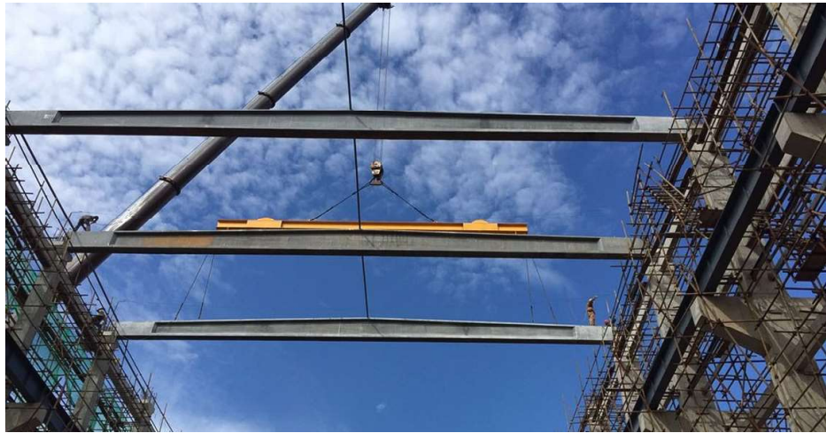
Fig. 2.20. Construcción industrializada de cubierta de fábrica empleando vigas pretensadas en UHPFRC, Wuhan, China, 2017.
