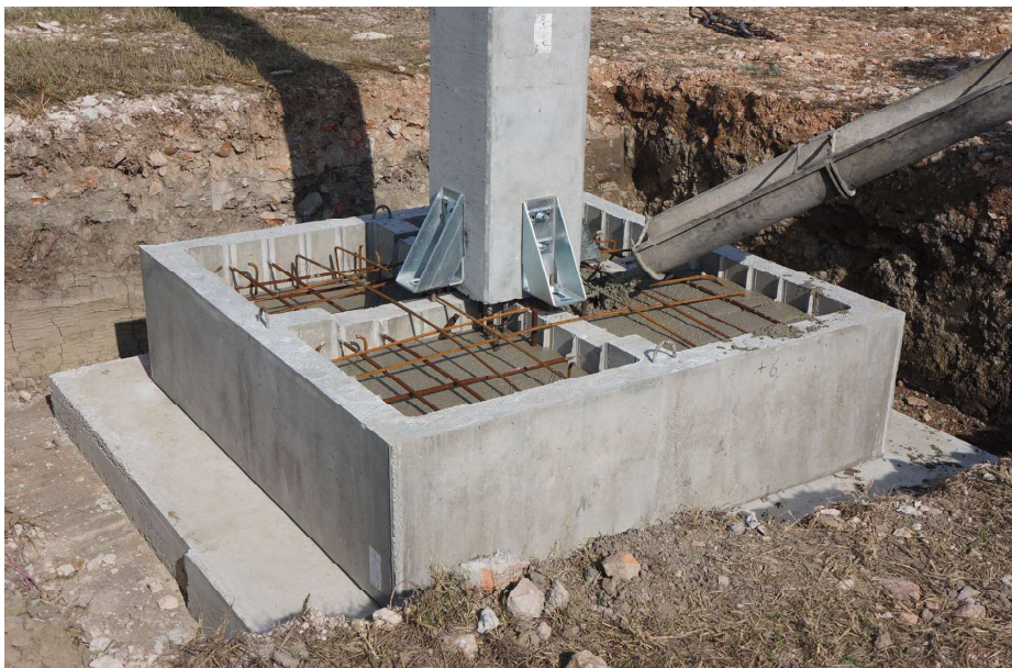
Fig. 2.1. Hormigonado de zapata prefabricada Monachino. Sistema de cimentación con “pre-zapata” en hormigón armado tradicional.
