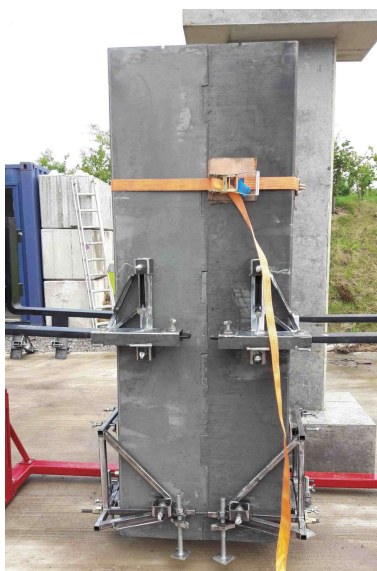
Fig. 2.13. (Izq.) Mitades separadas de encamisado de refuerzo ExoLeaf Freyssinet en UHPFRC.
