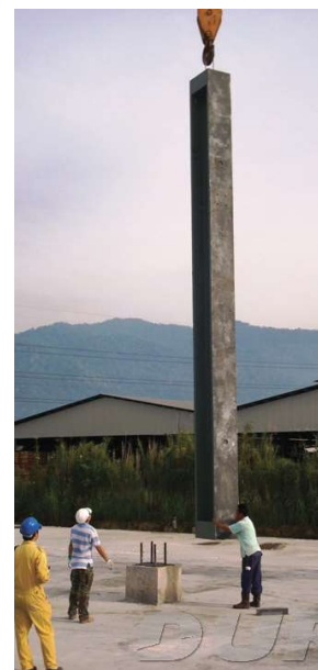
Fig. 2.17. Elevación y colocación del primer pilar de pórtico en la construcción del Wilson Hall.
