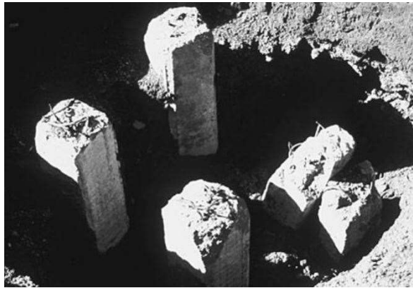
Fig. 2.2. (Izq.) Daños en la parte superior de pilotes hincados de hormigón armado por uso de tamaño incorrecto de martillo.
