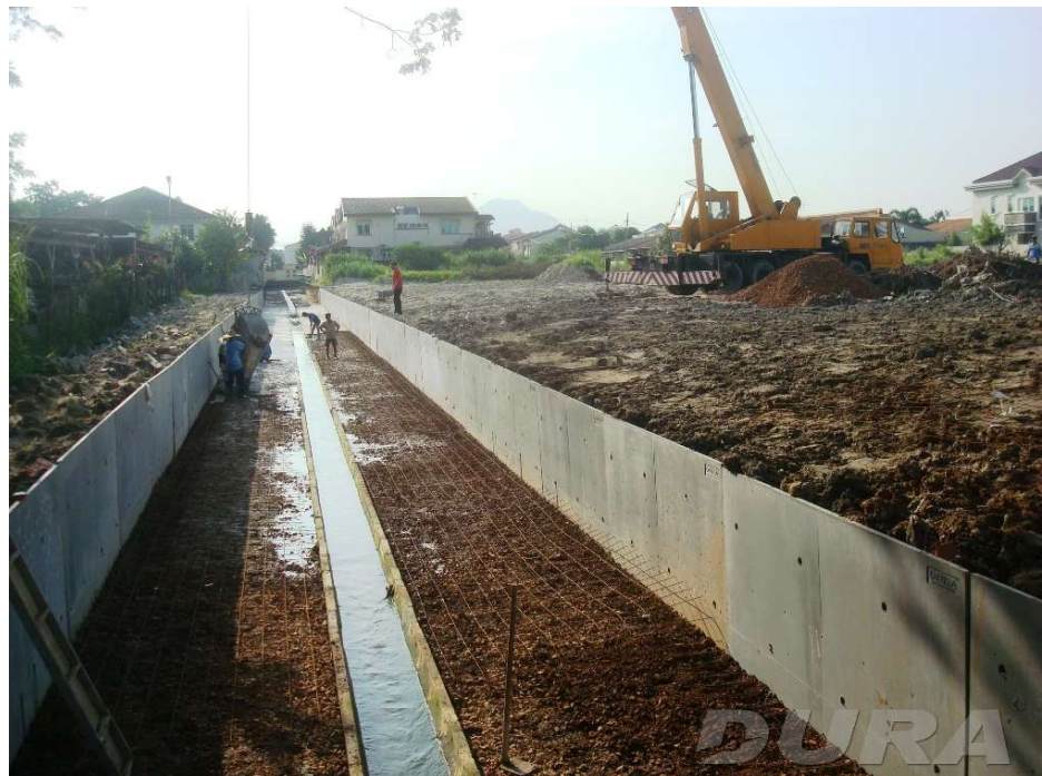
Fig. 2.9. Construcción de canal de drenaje de monzón para un proyecto residencial, empleando muro en L de contención ultraligero prefabricado en DURA-UHPC.
