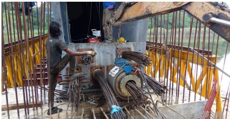
Fig. 2.21. Postensado in-situ de un puente-viga en U de UHPFRC en Malasia.
