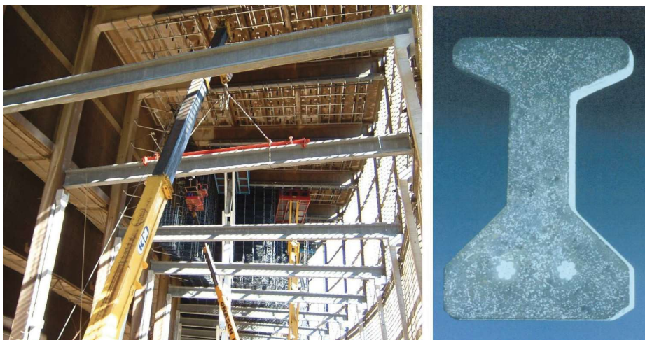
Fig. 2.19. Instalación y sección de viga prefabricada y pretensada en UHPFRC para proyecto de renovación en la planta de energía nuclear de Cattenom, Francia, 1997.
