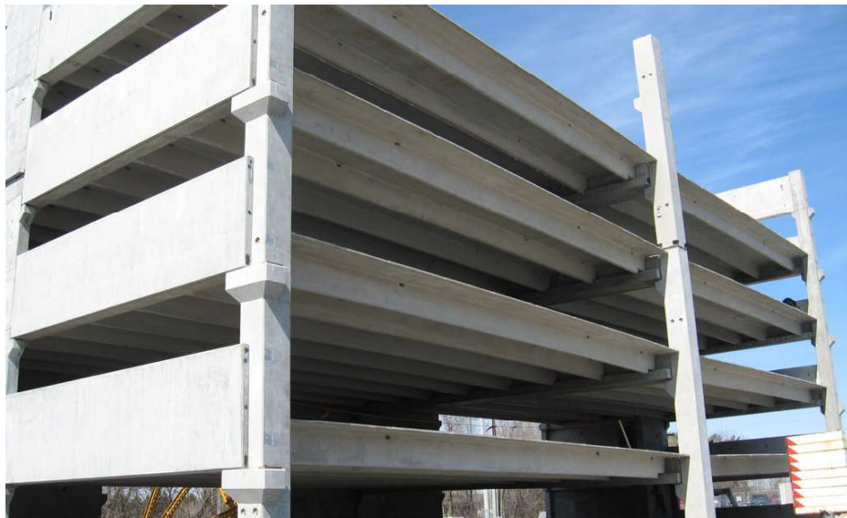
Fig. 2.26. Edificio de aparcamientos con estructura de piso ejecutada en losa de doble T.
