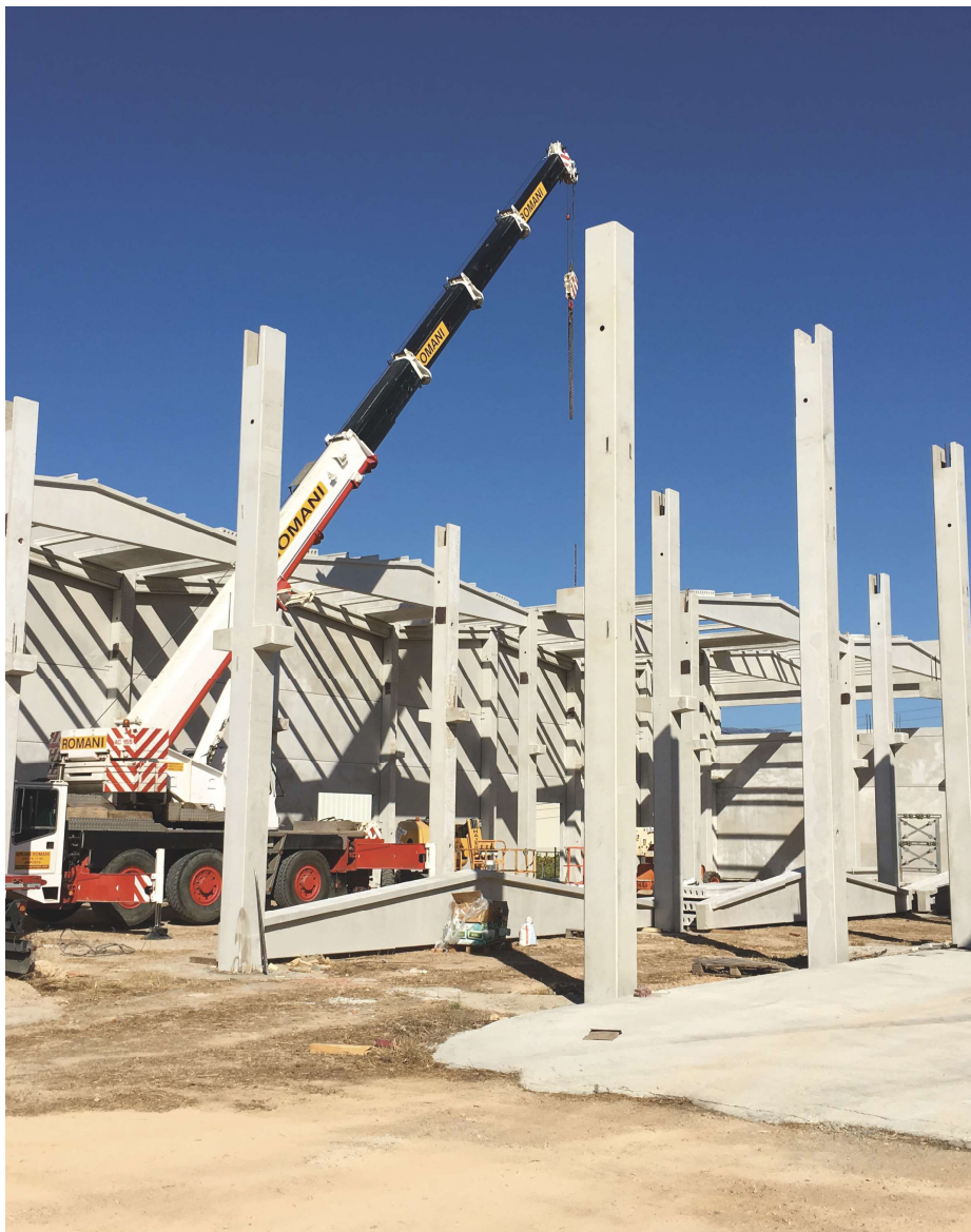
Fig. 3.7. Instalación de pilares prefabricados de hormigón armado con ménsula.
