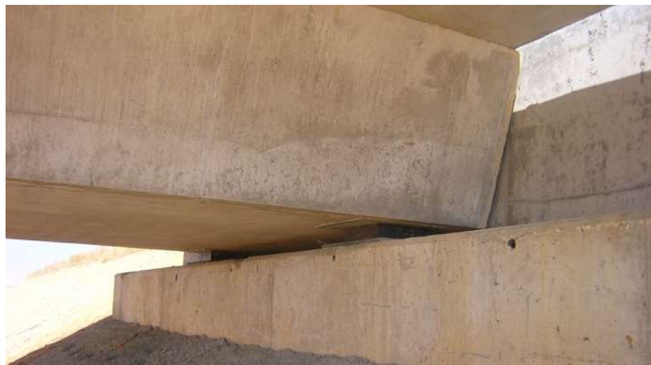
Fig. 3.8. Ejemplo de apoyo elastomérico de viga de puente.
