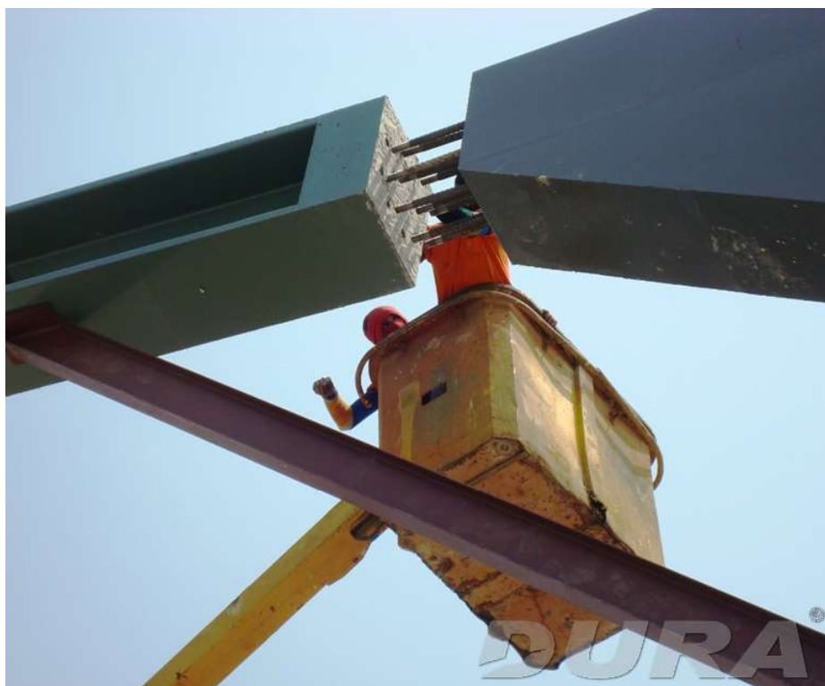
Fig. 3.10. Unión atornillada en seco de viga a conector de cumbrera en pórtico.
